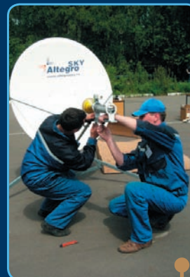
• Установка приемопередатчика на специальный держатель
