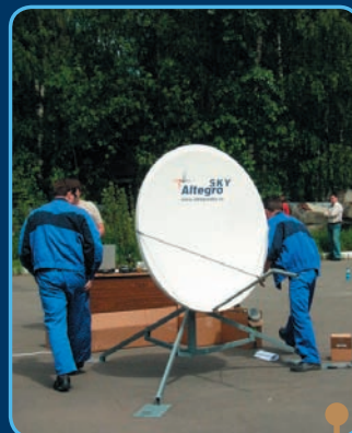
• Антенна надевается на опорно-поворотное устройство
