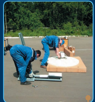
• Первый этап сборки — развернуть крепление и установить держатель на задней части антенны
