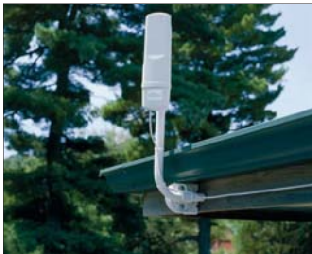
Абонентский модуль (Subscriber Module) – приемник интернет-доступа, устанавливаемый у клиента
